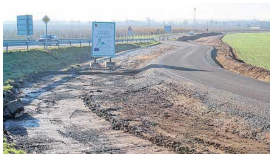
Noch ist alles ruhig: Der Start für den ersten Bauabschnitt auf der Wurzener und Torgauer Straße wurde auf 2014 verschoben. Foto: Klaus Peschel
